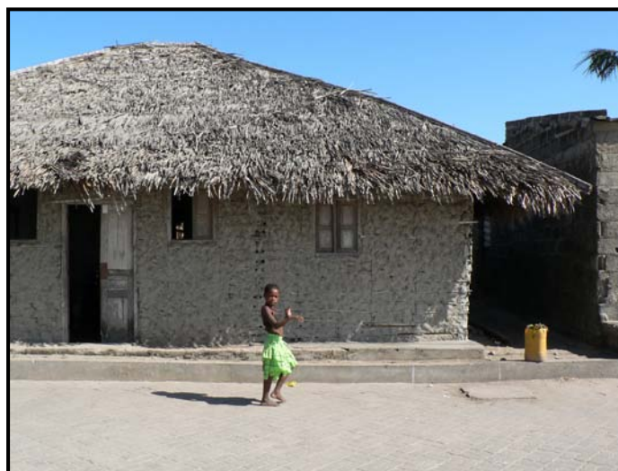
Fig. 13. Construção de modelo tradicional com cobertura de macuti.
