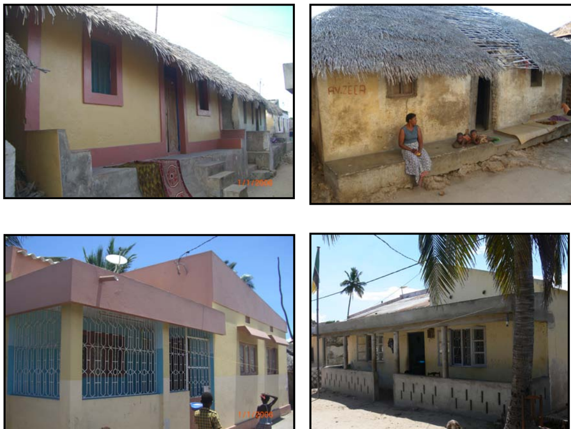
Fig. 14. Diferentes modelos da arquitectura vernacular na Cidade de Macuti (Fotos de José Forjaz Arquitectos 2010).
