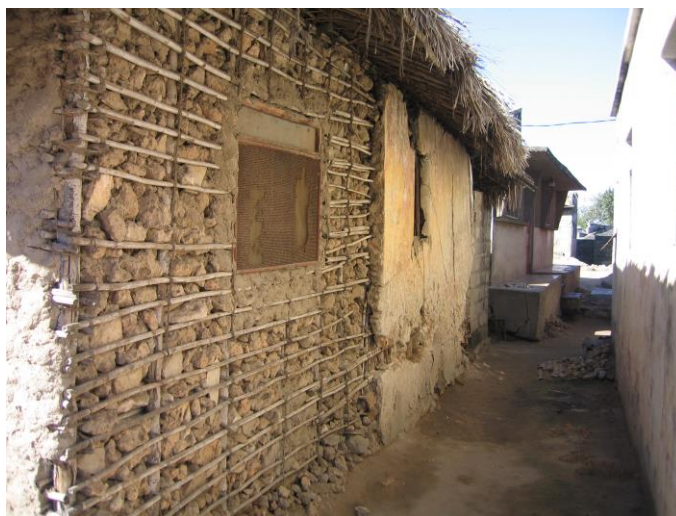
Estrutura de pau-a-pique
