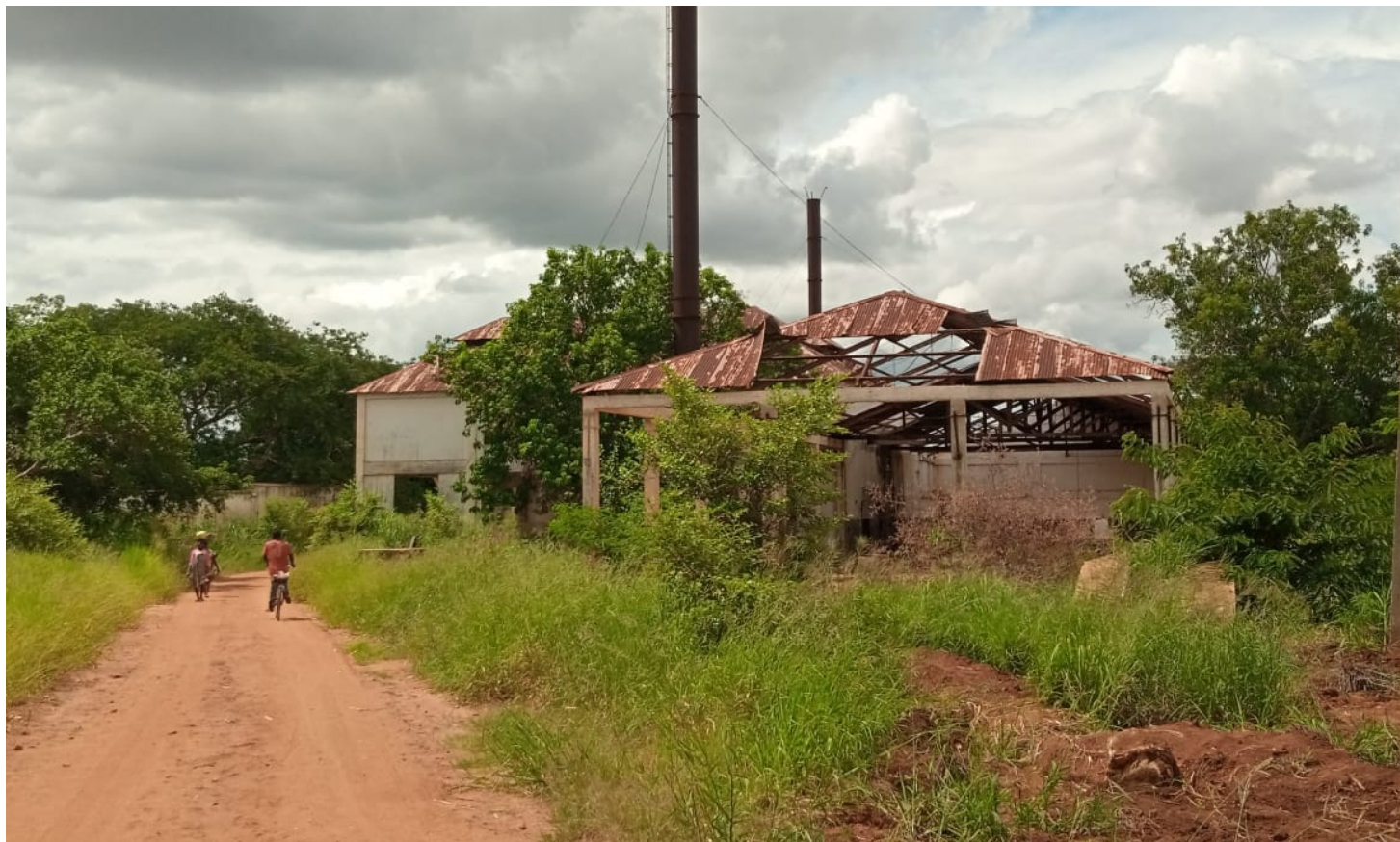
Escombros da então fábrica de processamento de sisal de Miserepane.
